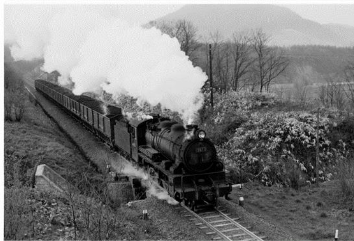
4.「紅葉山・沼ノ沢間を行く19673による貨物列車」 伊藤保則さん撮影、1969年
