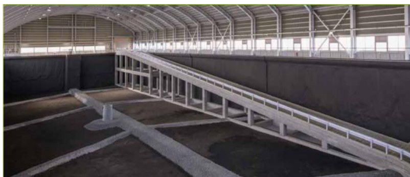
出典：西濃環境整備組合一般廃棄物最終処分場パンフレット 図 4-18 クローズドシステム処分場の事例
