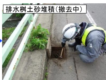
(排水柵土砂堆積清掃)
