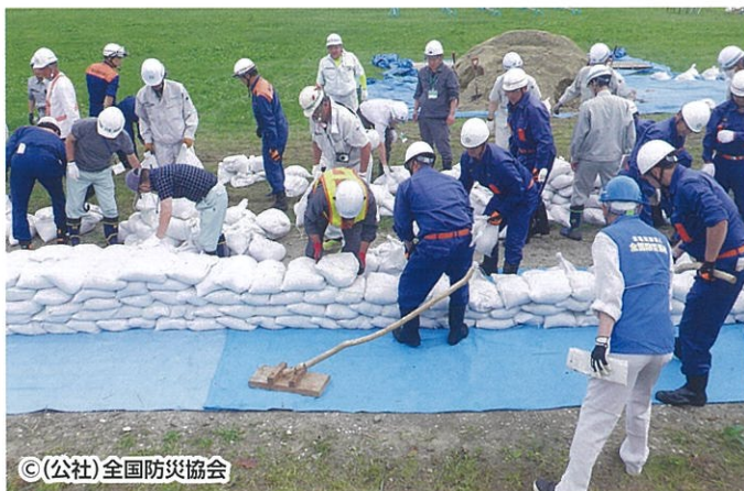
水防専門家の指導 積み土のう工(杭省略型)
