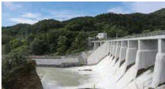
1940(昭和15)年に、北炭が清水沢火力発電所の冷却水を取得する目的でダムと水力発電所を設置しました。1953(昭和28)年、農業用水確保のためダムを嵩上げし、ゲートを設置しました。周辺炭鉱の閉山に伴い1994(平成6)年に北海道企業局へ譲渡。改修工事のため2016(平成28)年にゲートを撤去。2021(令和3)年4月から140m下流に新発電所が完成し、営業運転を再開しました。
