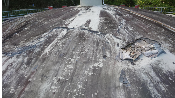
屋根の防水層【張替前】
