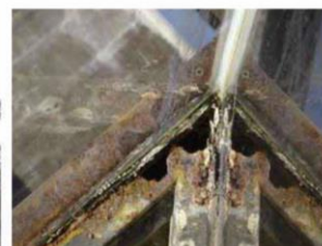
窓ガラス落下の恐れがあった出窓と、腐食した窓枠
