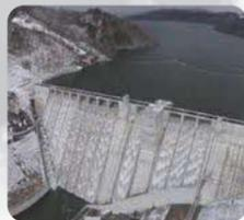
石狩川水系夕張川の上流に位置する重力式コンクリートダムです。湛水面積15.0km<sup>2</sup>は全国2位、総貯水容量42,700万m<sup>3</sup>は全国4位の圧倒的スケールを誇る多目的ダムとして知られています。
