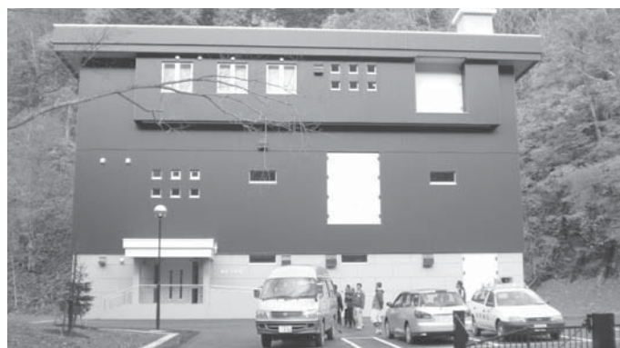
旭町・清水沢の両浄水場
