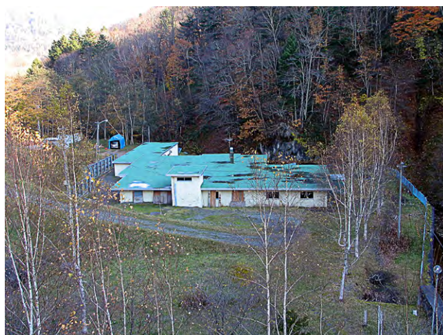
現在の浄水場全景(着手前)
