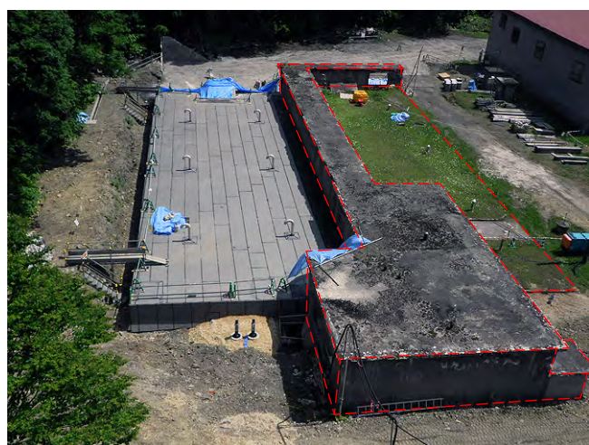
浄水池(写真左)に防水シート貼付け ※赤枠箇所は最終的に撤去します
