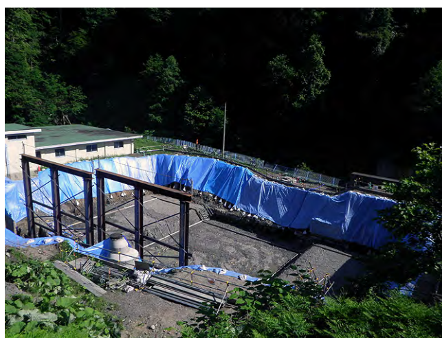
地下埋設物撤去・作業台構築
