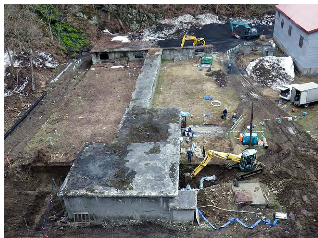
浄水池の改修・一部撤去
