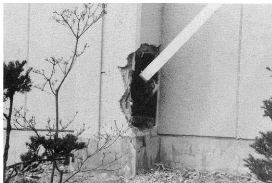
写真2-3 筋違の破断
