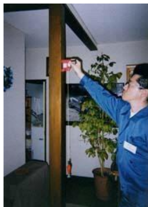
写真1-5 下げ振りによる傾斜の測定
