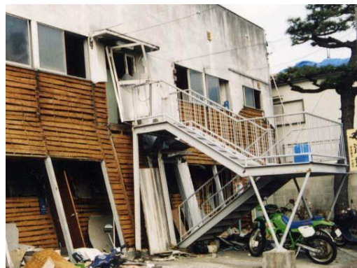
写真1-19 屋外階段の傾斜被害(Cランク)
