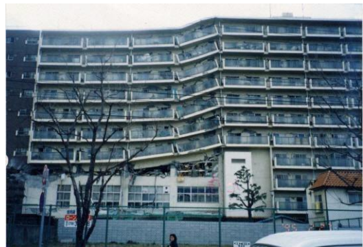
写真3-14 構造躯体の損傷による部分的な傾斜
