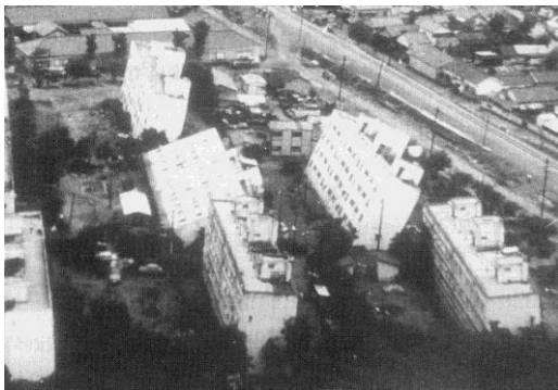
写真3-13 全体沈下と全体傾斜
