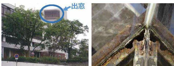
窓ガラス落下の恐れがあった出窓と、腐食した窓枠
