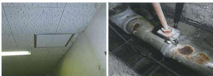
漏水により変色した壁と、数十か所にしみ漏れが見つかった配管
