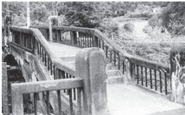
↑傾斜のある橋桁がわかる
