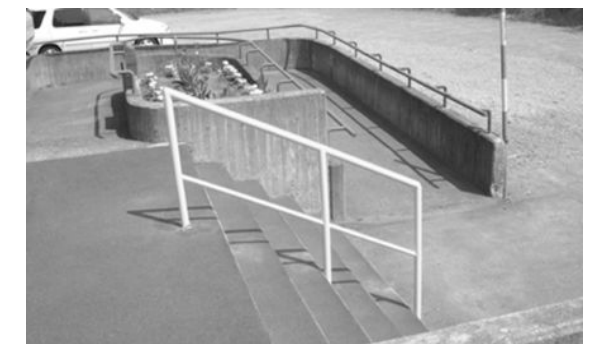
南支所の玄関階段手すりの設置工事
