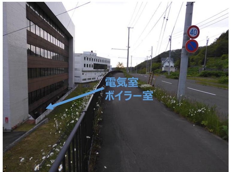
低階層に位置する電気室・ボイラー室
