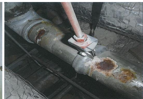
漏水により変色した壁と、数十か所にしみ漏れが見つかった配管
