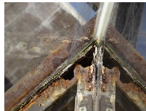
窓ガラス落下の恐れがあった出窓と、腐食した窓枠
