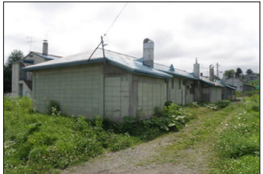
【補強コンクリートブロック造 1階建て】
