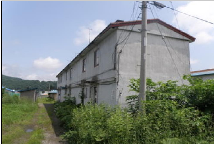
【補強コンクリートブロック造 2階建て】
